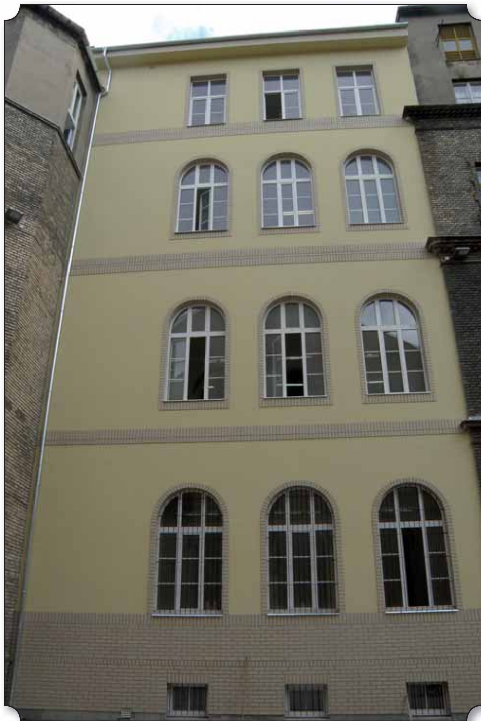
A 2010 júniusában átadott új épületrész homlokzata
